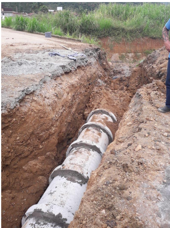
Tubulação REJEITADA (Rejunta pela metade)
