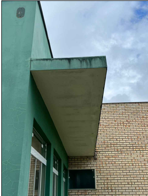
FOTO 26 - TRATAMENTO DE TRINCAS, FISSURAS E RACHADURAS E IMPERMEABILIZAÇÃO DE MARQUISE
