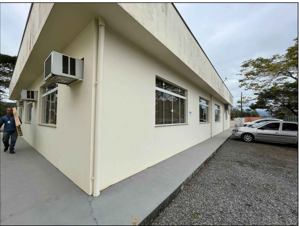
FOTO 04 - JANELAS A SEREM REMOVIDAS E FECHADAS COM ALVENARIA
