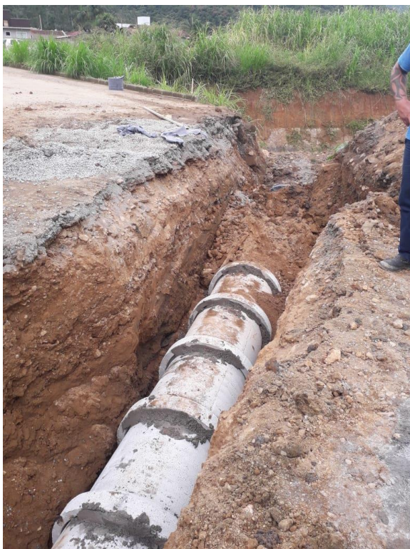
Tubulação REJEITADA (Rejunta pela metade)
