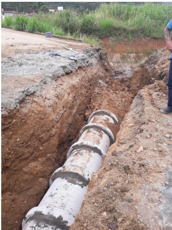
Tubulação REJEITADA (Rejunte pela metade)
