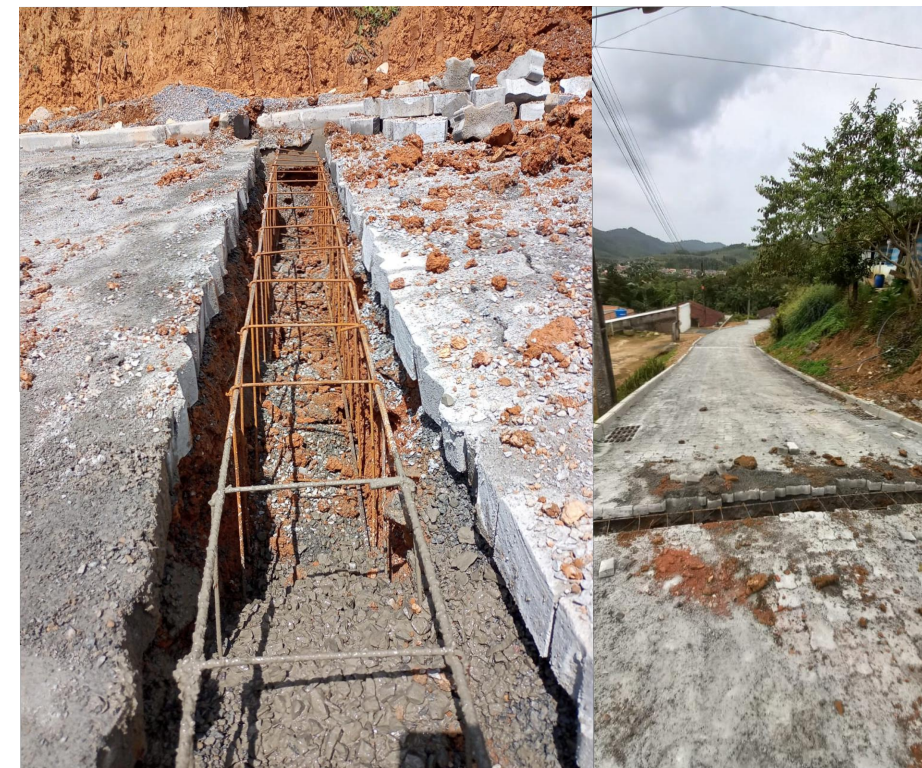
Fotos de execução de uma viga de travamento
