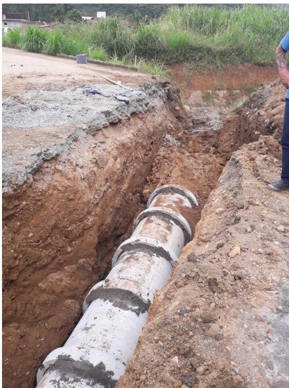
Tubulação REJEITADA (Rejunta pela metade)
