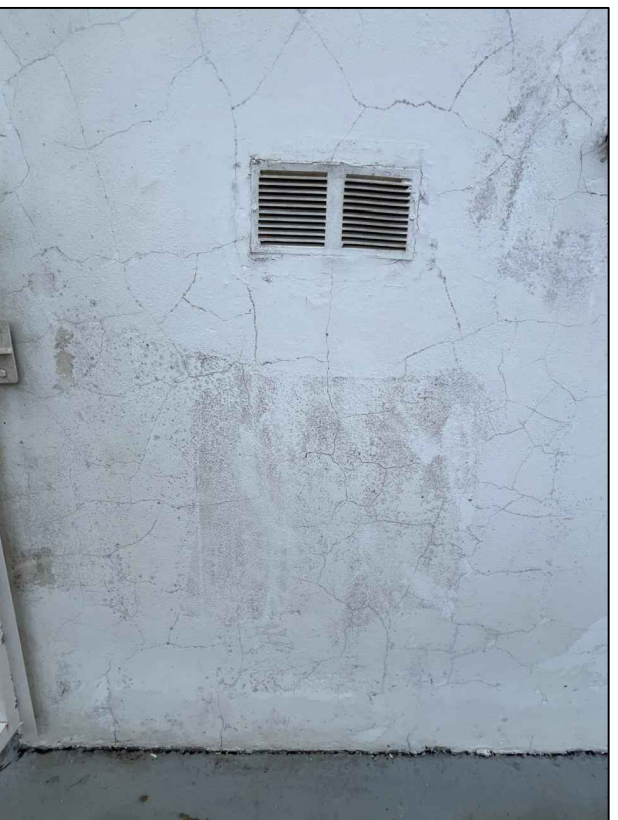
FOTO 59 - REPARO DAS FISSURAS, TRINCAS E RACHADURAS
