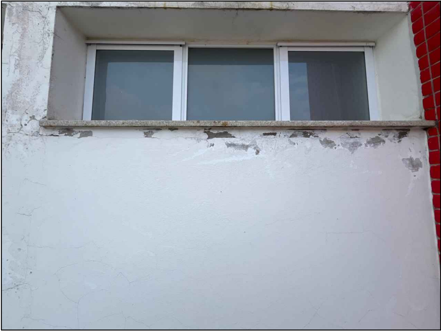
FOTO 62 - REPARO DAS FISSURAS, TRINCAS,RACHADURAS E INFILTRAÇÕES
