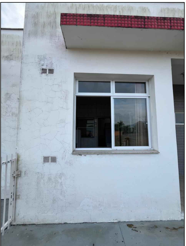
FOTO 56 - REPARO DAS FISSURAS, TRINCAS E RACHADURAS
