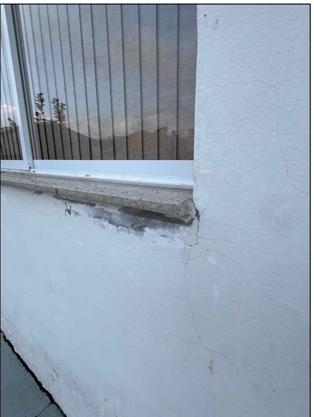
FOTO 58 - TRATAMENTO DA INFILTRAÇÃO
