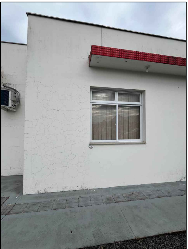
FOTO 31 - REPARO DAS FISSURAS, TRINCAS E RACHADURAS
