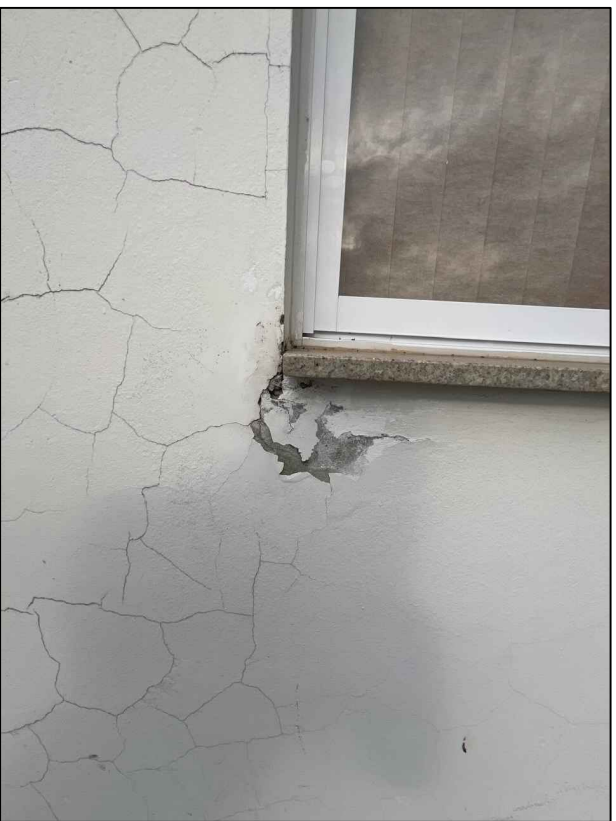
FOTO 50 - REPARO DAS FISSURAS, TRINCAS E RACHADURAS
