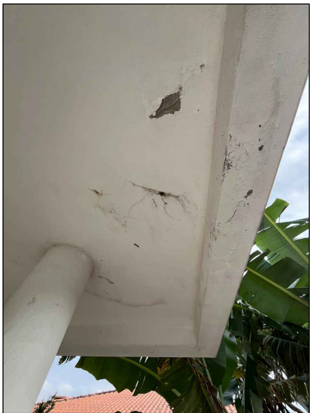
FOTO 47 - TRATAMENTO DA INFILTRAÇÃO
