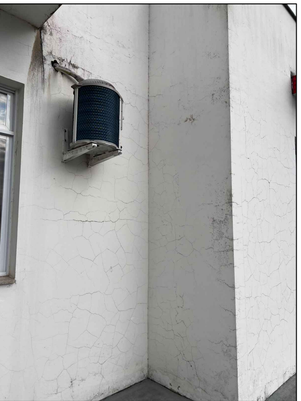
FOTO 52 - REPARO DAS FISSURAS, TRINCAS E RACHADURAS
