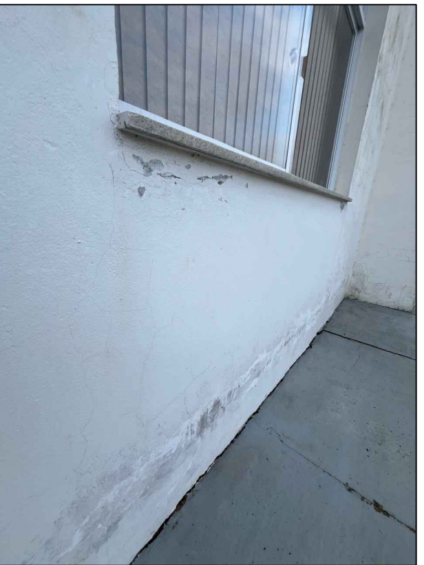
FOTO 45 - REPARO DAS FISSURAS, TRINCAS E RACHADURAS
