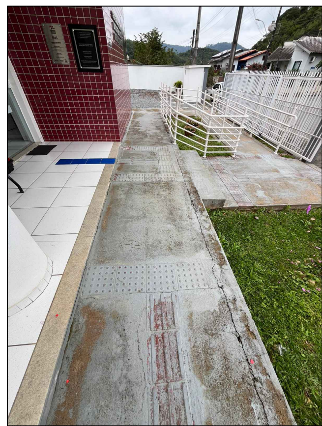
FOTO 65 - LIMPEZA COM JATO + REPAROS + PINTURA
