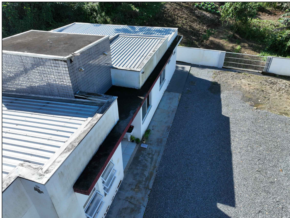
FOTO 8 - LIMPEZA DO TELHADO + IMPERMEABILIZAÇÃO DE MARQUISE
