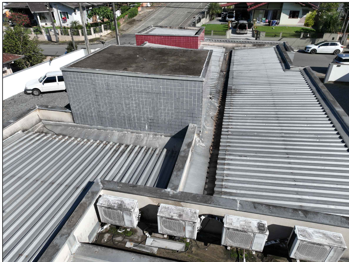
FOTO 7 - LIMPEZA DO TELHADO + IMPERMEABILIZAÇÃO DE MARQUISE
