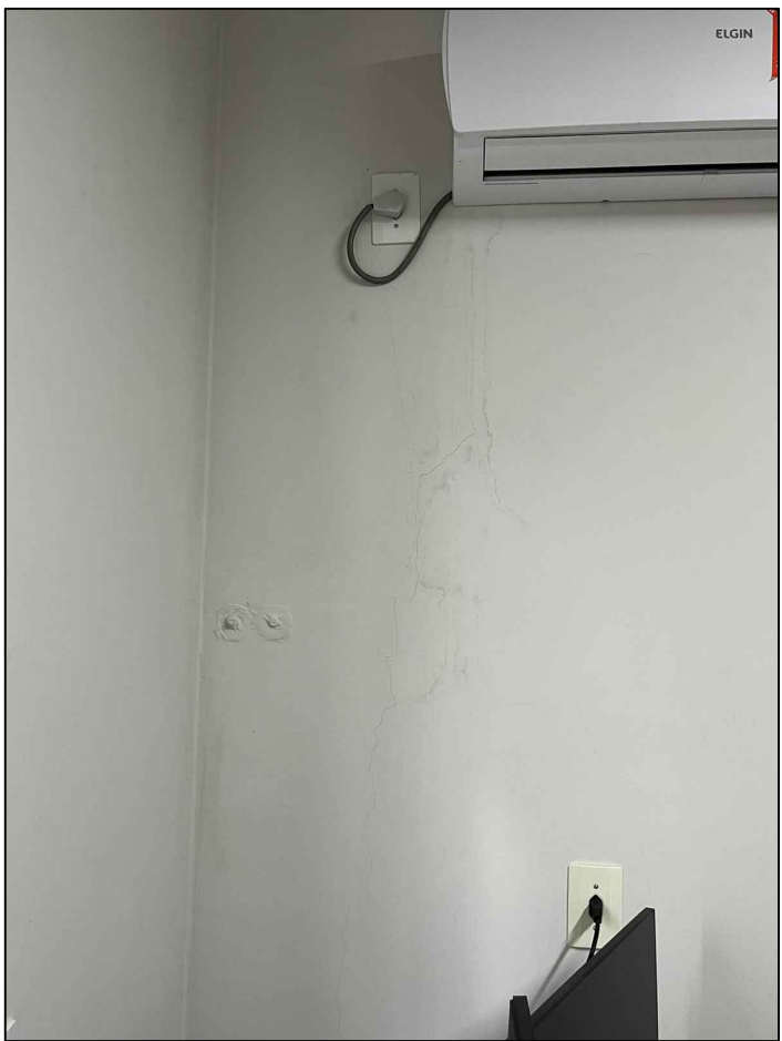
FOTO 36 - TRATAMENTO DE TRINCAS, FISSURAS E RACHADURAS
