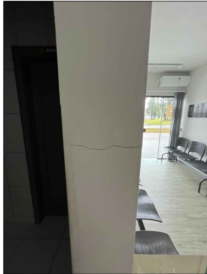
FOTO 40 - TRATAMENTO DE TRINCAS, FISSURAS E RACHADURAS
