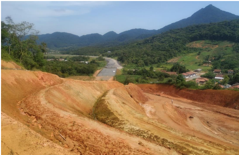
Figura 117. Obras do contorno viário da BR-280 no bairro Schroeder I, no município de Schroeder.
