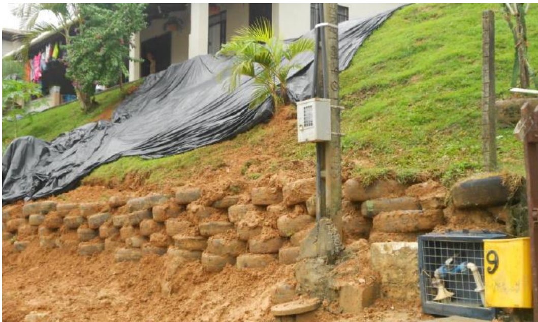
Figura 84. Movimento de Terra na Rua Guilherme Daren, no bairro Schroeder I.
