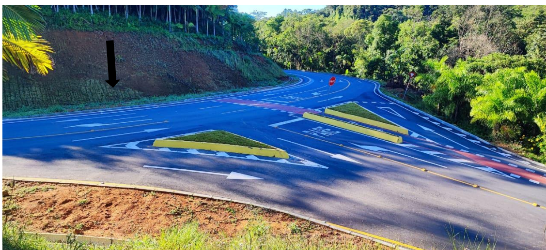
Um canteiro lateral parte superior
