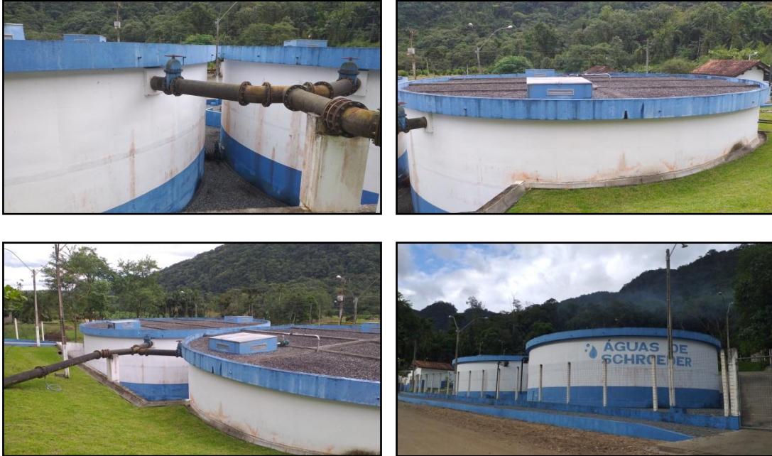
Figura 3.19 - Reservatórios R2 e R3 de distribuição de água anexos a ETA Bracinho.
