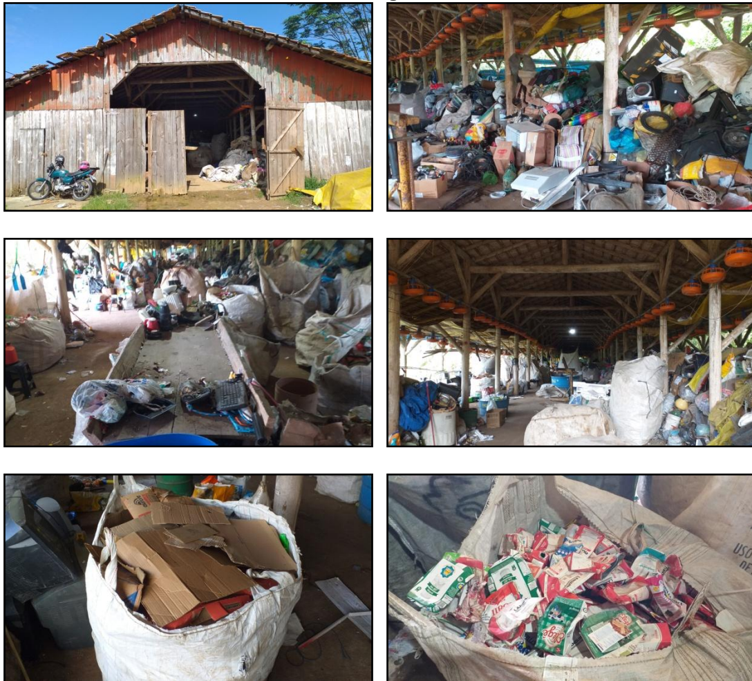
Figura 3.36 - Barracão de triagem de resíduos recicláveis no bairro Braço do Sul da Empresa Lang.
