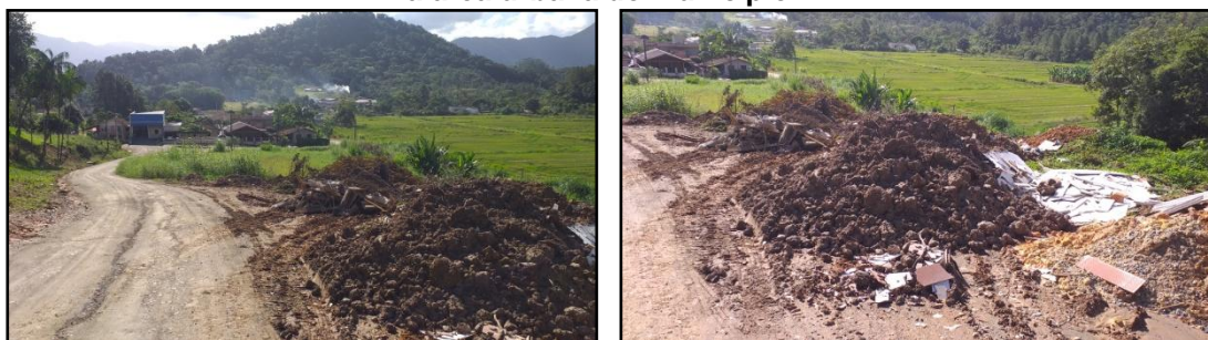
Figura 3.47 - Resíduos da construção civil utilizados na manutenção de estrada em via pública na área urbana do município.
