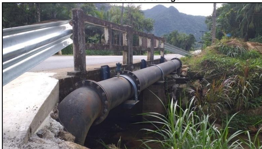
Figura 3.22 - Adutora de água tratada do SAA Águas de Schroeder com trecho de ferro fundido em travessia de córrego.
