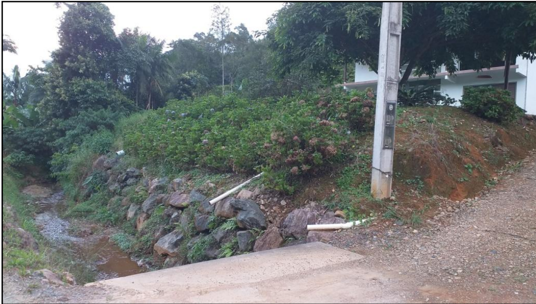
Figura 3.26 - Lançamento de esgoto doméstico tratado em sistema individual na rede de drenagem fluvial na área urbana do município.
