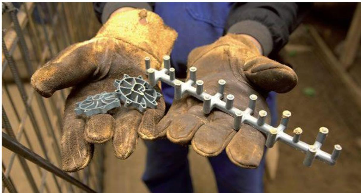
Espaçadores - metálicos, plásticos ou em argamassa - posicionam e mantêm a armadura durante a concretagem, garantindo o cobrimento pelo concreto, evitando exposição e corrosão do aço. Há espaçadores, como o caranguejo e as pastilhas argamassadas, que podem ser adaptados na própria central de corte e dobra do canteiro. Apesar de mais baratos, diminuem a velocidade da obra. Já peças
