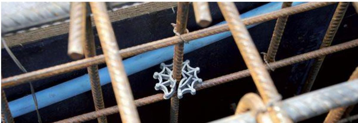
**Espaçador com entrada radial:** indicado para armaduras pesadas, como sapatas e blocos de fundação, é feito em plástico, possui modelo circular e pode ser encaixado com a armadura montada.
