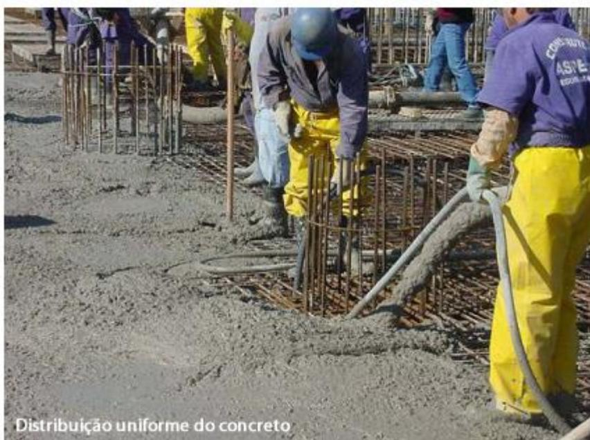
Quando o lançamento é interrompido, formam-se juntas de concretagem, que devem ser tratadas, para garantir a ligação do concreto endurecido com o novo. Para isso, os locais da parada de concretagem devem ser estudados previamente, de modo que estejam localizadas em seções pouco solicitadas, para não influir no comportamento da estrutura. Em locais de maior solicitação, deve-se aplicar um adesivo estrutural na junta.
