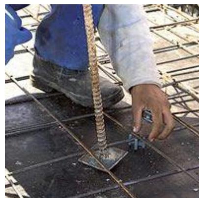
Alguns tipos de espaçadores podem ser posicionados após a
