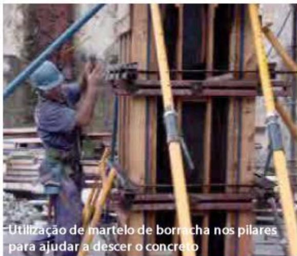
Utilização de martelo de borracha nos pilares para ajudar a descer o concreto
