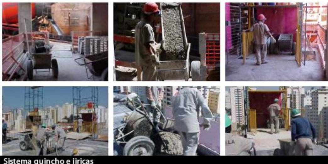
O sistema de transporte deve ser tal que permita o lançamento direto nas fôrmas, evitando-se depósitos intermediários ou transferência de equipamentos. O tempo de duração do transporte deve ser o menor possível, para minimizar os efeitos relativos à redução da trabalhabilidade com o passar do tempo. De acordo com o grau de racionalização proporcionado pelo sistema de transporte, podemos classificá-los como:
