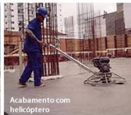
Ganhos de produtividade podem ser obtidos com o uso de desempenadeiras motorizadas, devendo ser aplicadas a partir do instante em que for possível caminhar sobre o concreto, e sem esse estar completamente endurecido. O momento adequado para essa operação ocorre quando o concreto suporta a pressão do operário, deixando apenas uma pequena marca da bota, com cerca de 2 mm de profundidade.
