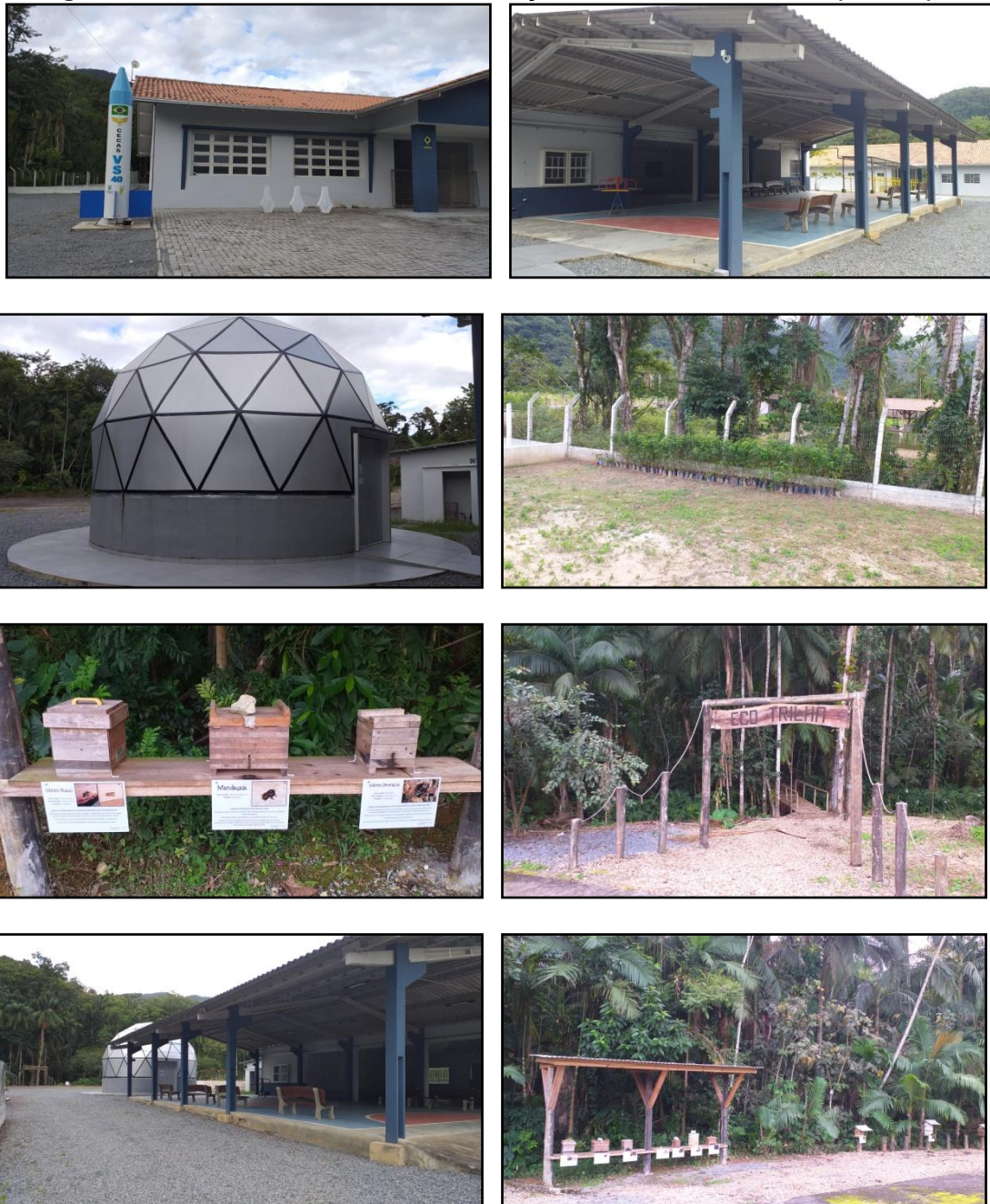
Figura 3.40. Estrutura do Centro de Educação Científica e Ambiental (CECAS).
