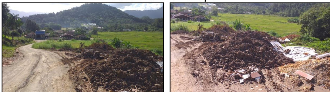
Figura 3.47. Resíduos da construção civil utilizados na manutenção de estrada em via pública na área urbana do município.
