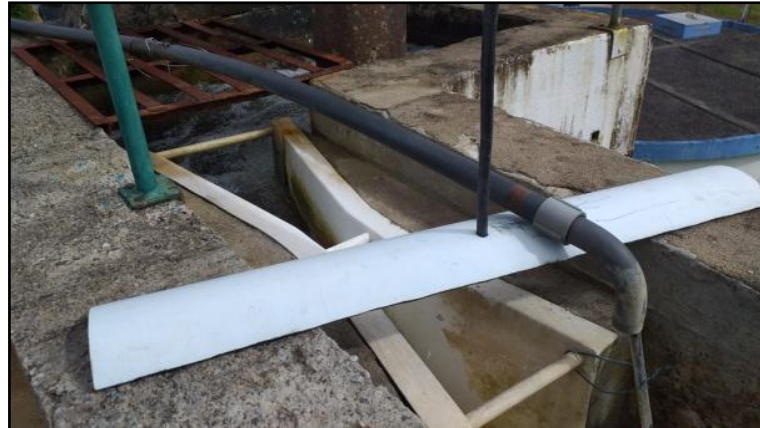
Figura 3.12. Calha Parshall da ETA Bracinho.
