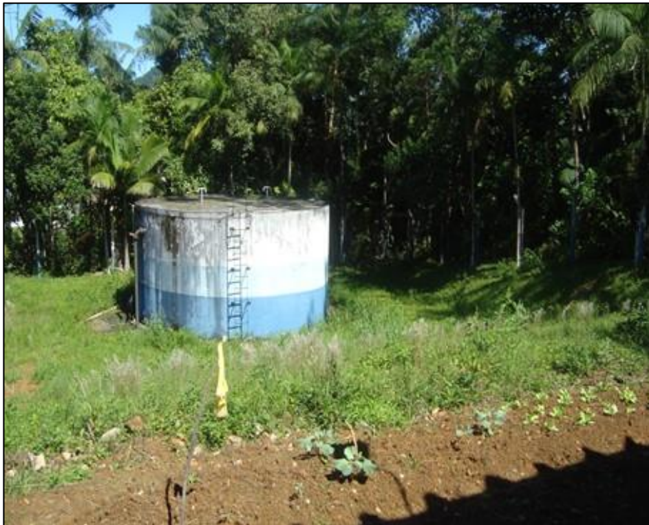
Figura 20 – Reservatório R2 - Desativado
