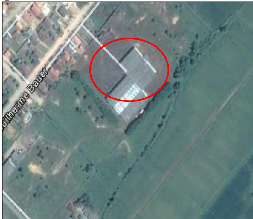
Figura 39 – Antiga central de tratamento de resíduos industriais
