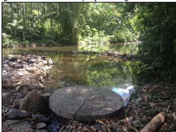
Figura 17 – Caixa de captação de água do Rio Bracinho
