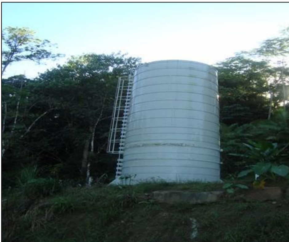
Figura 21 – Reservatório R3 – Dentro da ETA
