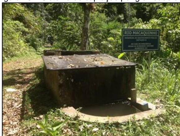
Figura 15 – Sistema de captação por gravidade do Rio Macaquinho
