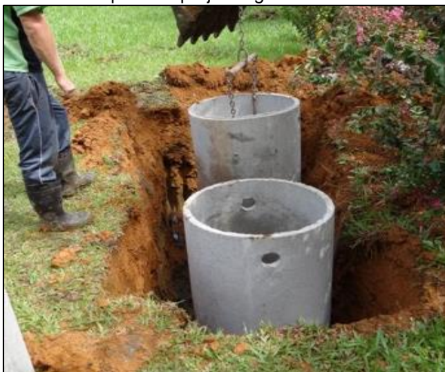
Figura 34 – Instalação de fossa séptica do projeto Água Pura da Serra do Mar na Torneira
