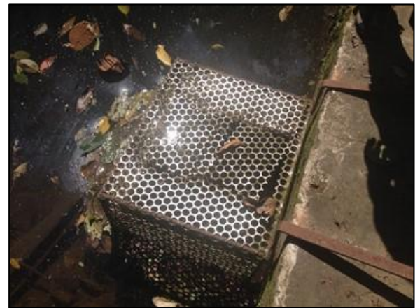
Figura 15 – Sistema de captação por gravidade do Rio Macaquinho
