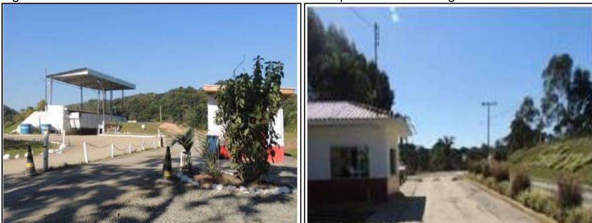
Figura 36 – Área de transbordo e aterro sanitário da empresa Serrana Engenharia Ltda.
