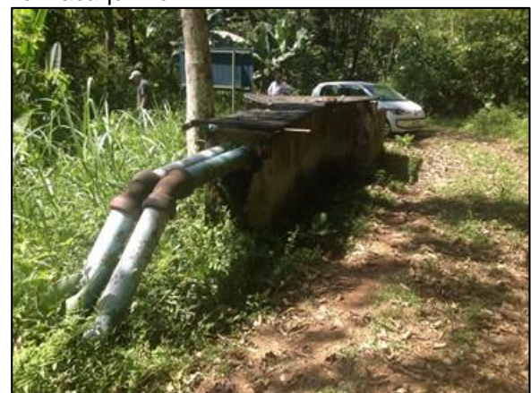
Figura 15 – Sistema de captação por gravidade do Rio Macaquinho
